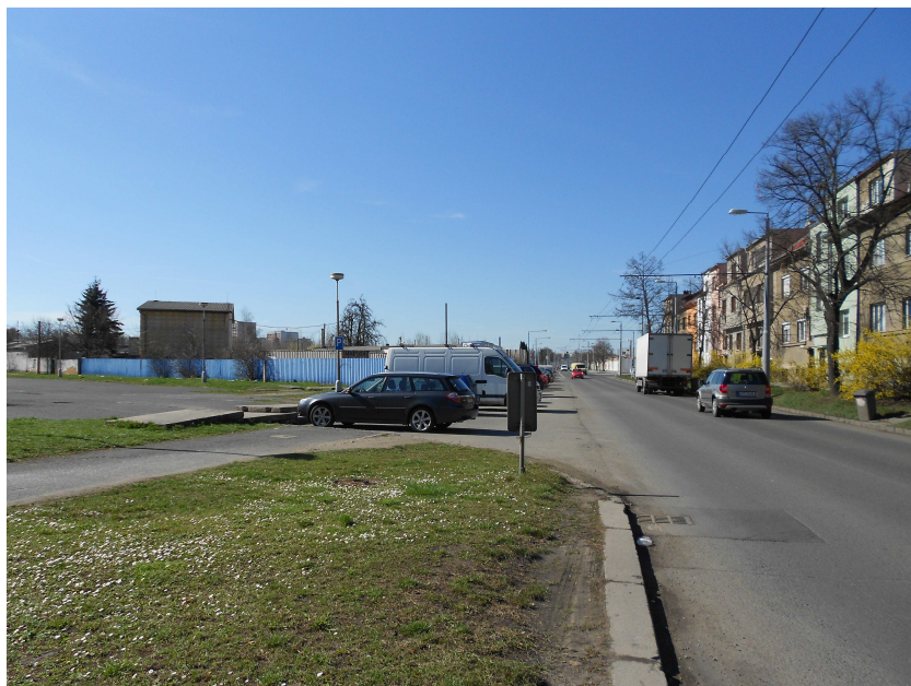
Obr.č.21 Pohled na ulici Borskou v místě plánované okružní křižovatky.
