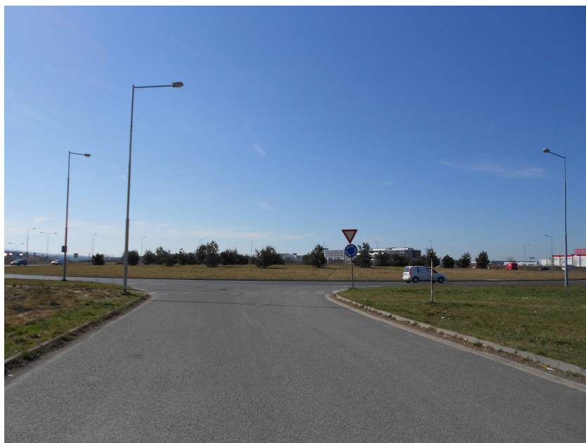
Obr.č.17 Pohled na začátek stavby na kruhovém objezdu na Sukově ulici.
