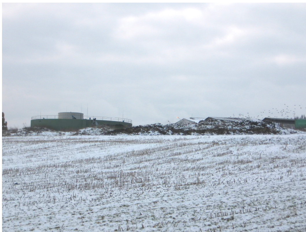
Pohled na místo stavby
