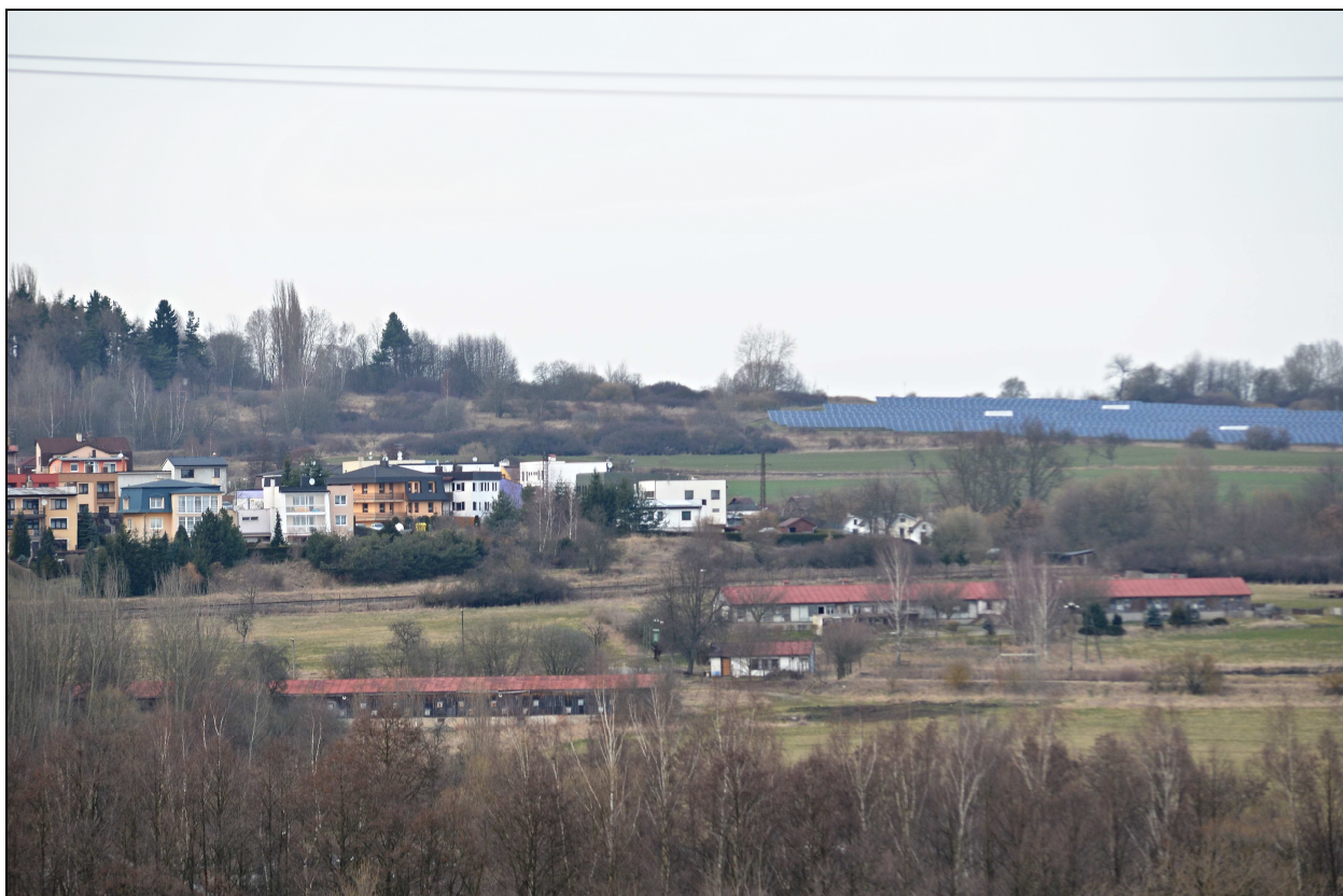
Dálkový pohled od jihu (vpravo nahoře solární elektrárna)
