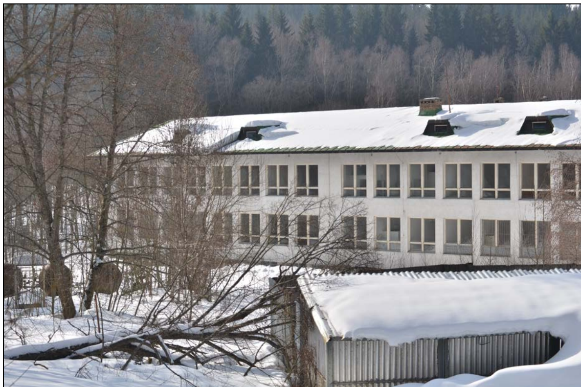
Stávající stav objektů (02/2018), pohled od východu
