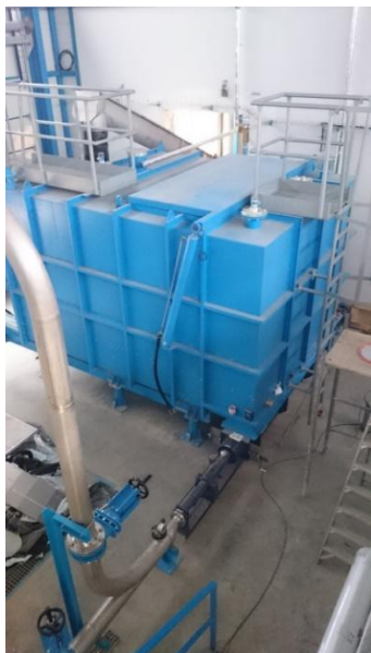
dávkování odvodněného kalu (KKT) do procesu sušení a těleso pásové sušárny STC
