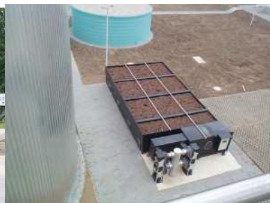
čištění odpadního vzduchu (pračka + biofiltr)
