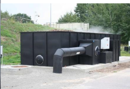
čištění odpadního vzduchu (pračka + biofiltr)
