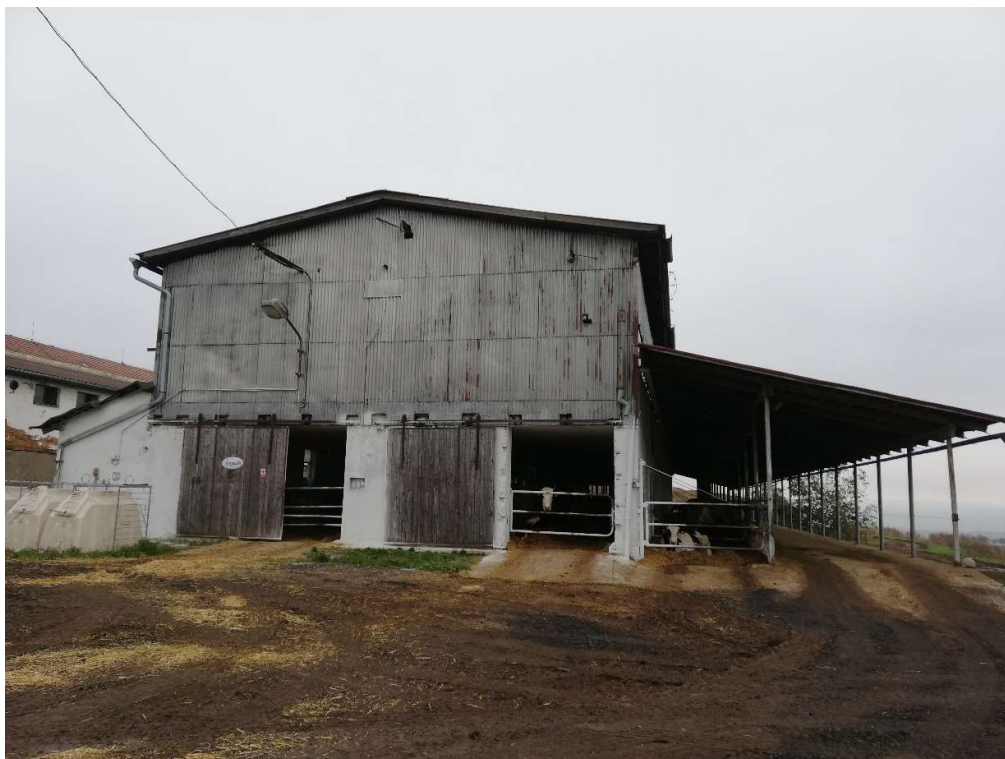
Pohled na stáj určenou k demolici
