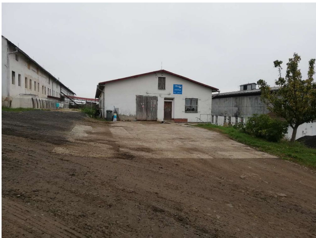
Dojírna určená k rekonstrukci
