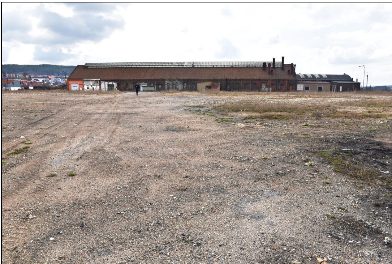
Pohled na zájmové území jižním směrem (ke starým objektům)
