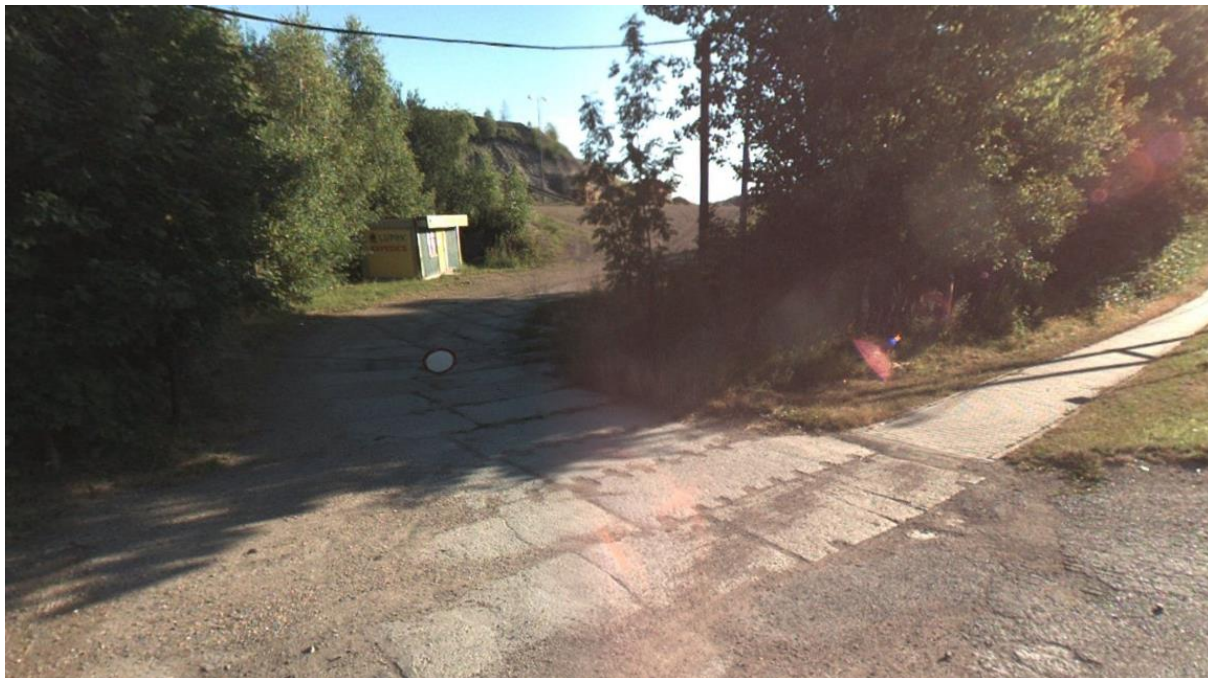
Obr.č. 25 : Vjezd do areálu
