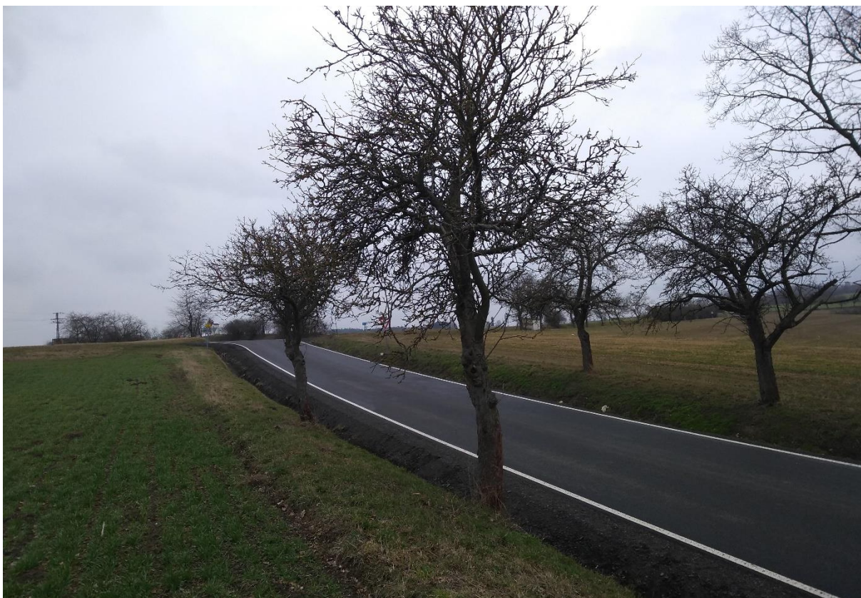
Foto 7: Pohled od Štáhlav na místo křížení silnic I/19 a II183. Vznikne zde kruhový objezd.
