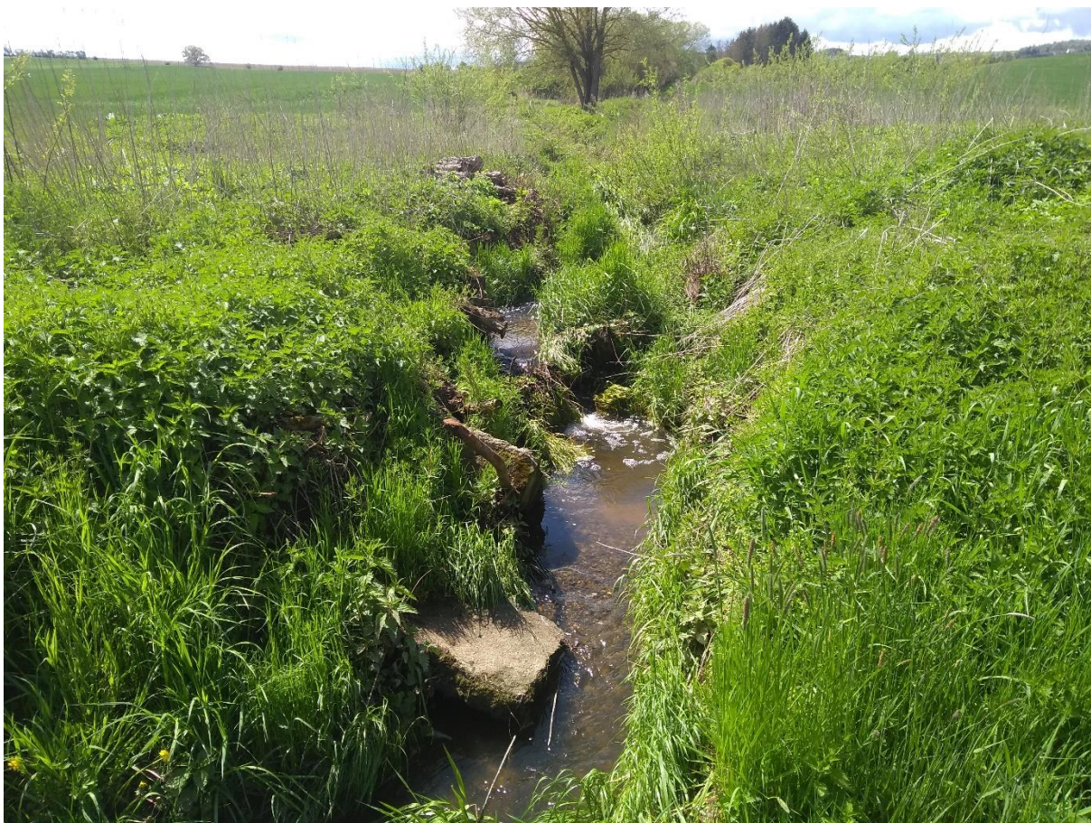
Foto 14: Pohled na koryto Nezbavětického potoka severně od stávající silnice. Potok byl v minulosti necitlivě upraven a jeho niva degradovala. Betonové opevnění koryta se rozpadá.
