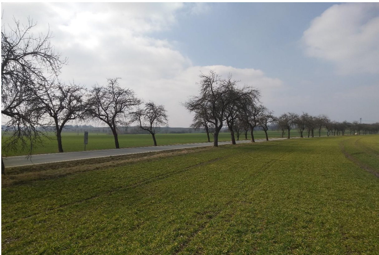
Foto 12: Stávající silnice III/1773 bude vedena novou trasou poli na jih od ní. Stávající silnice bude demolována a rekultivována na ornou půdu. Budou vykáceny všechny stromy, které jí lemují. V naprosté většině se jedná o staré stromy s výrazným výskytem vad a malou perspektivou dalšího růstu. Jejich náhradu za nové výsadby u nové trasy považujeme za vhodnou.
