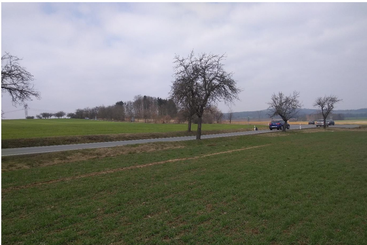
Foto 10: Současná křižovatka I/19, III/1772 a III/1773. Která zanikne a přesune se na kruhový objezd, který bude ležet jižněji.
