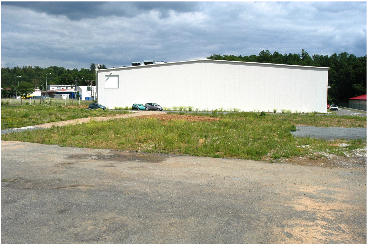
Pohled z místa budoucí stavby na stávající halu
