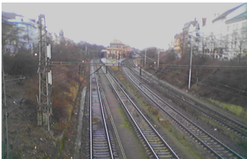
Obr.č.2 – pohled k západu k mostu přes komunikaci za hl.nádražím
