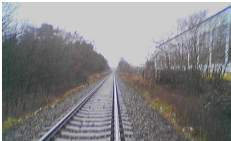
Obr.č. 6 – pohled k severu na bor u trati na Domažlice
