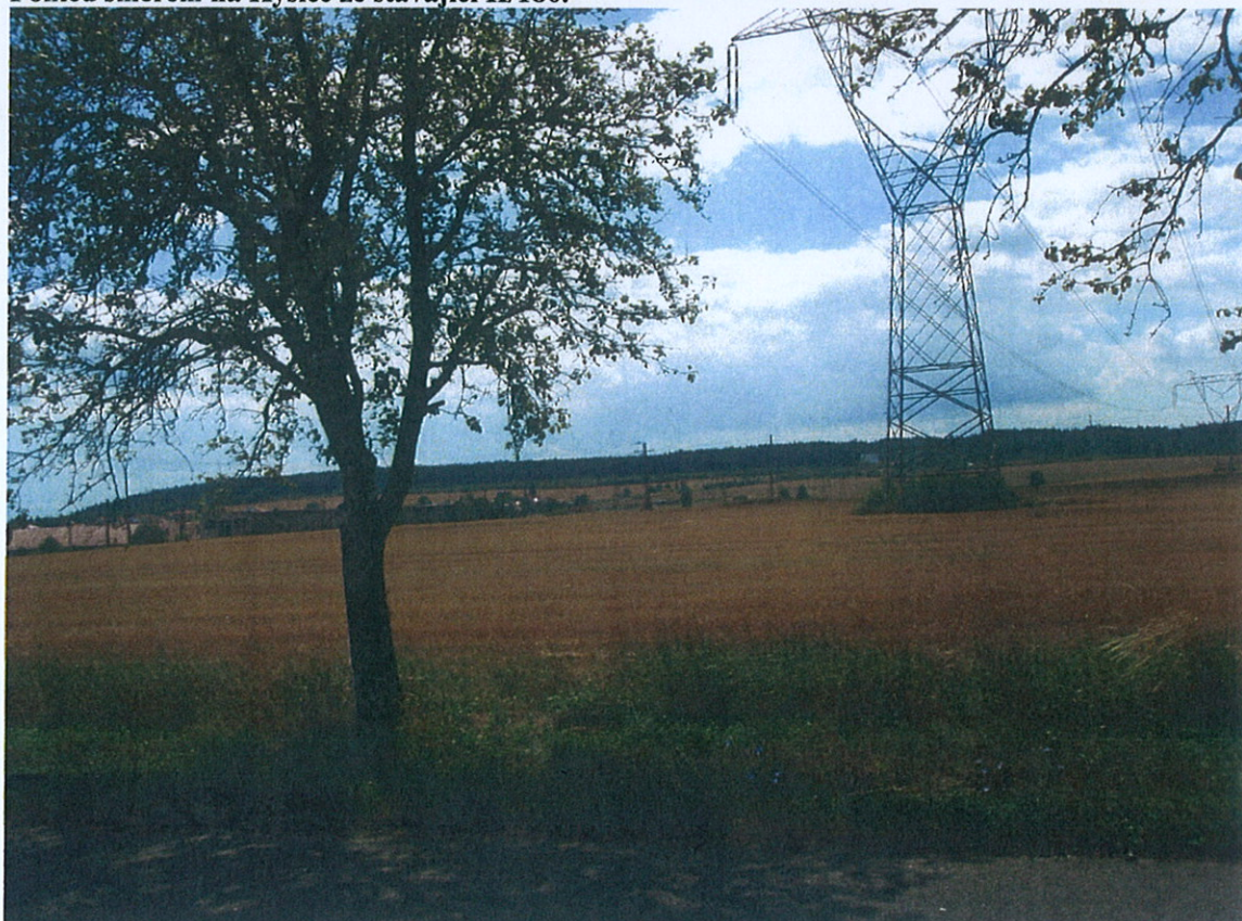
Pohled ve směru přeložky z místa křížení s komunikací Kyšice – Červený Hrádek v km 1,1.
