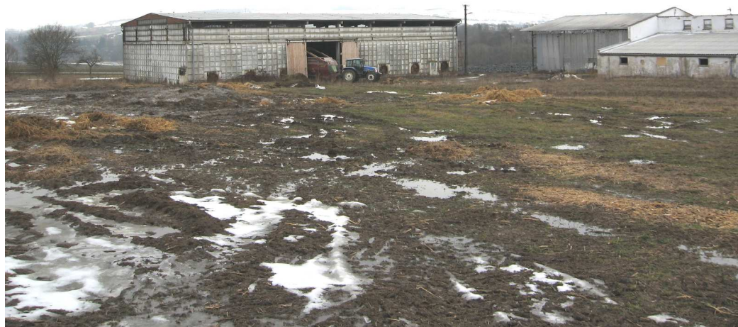
Pohled na místo výstavby nové stáje
