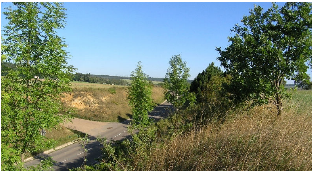
Foto 1: Pohled na počátek stavby km 0,000 – napojení sjezdu z dálnice D 5 směrem od Prahy na MUK Rokycany a stávající silnici III. třídy Rokycany – Litohlavy. Navrhovaná silnice se v tomto pohledu bude odklánět vpravo a bude vedena v zářezu. Stávající silnice do Litohlav bude zrušena a rekultivována.
