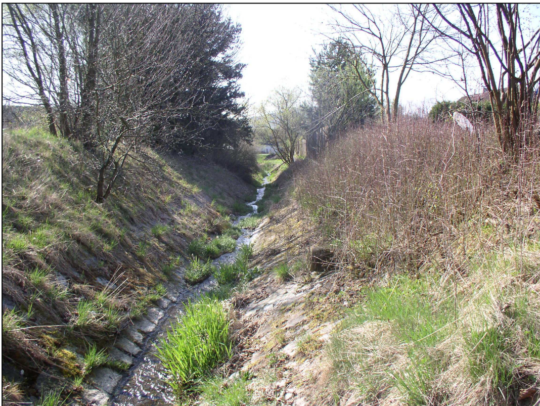
fotodokumentace č. 4 Bezejmenný levostranný přítok Úslavy před Kokořovem, který bude v rámci obchvatu (úsek č. 2) zatrubněn a přeložen – viz kap. B.I.6
