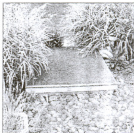
ČOV po osazení do země
