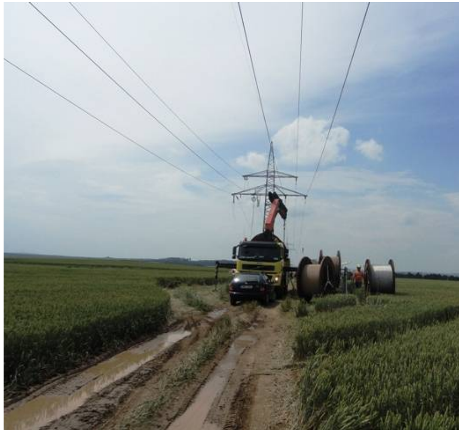
Instalace nových stožárů a vodičů tamtéž
