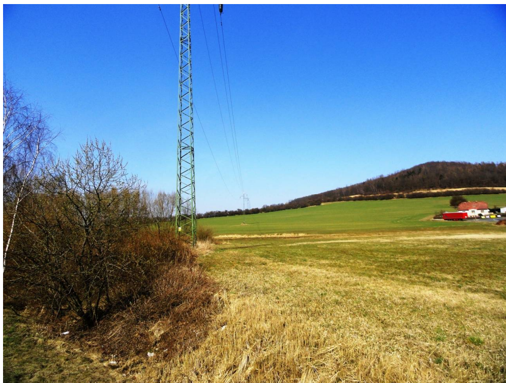
FOTO č. 13: Trasa s ST 33-39 u Kdyně před přechodem silnice I/22, vpravo pak je Kobyla
