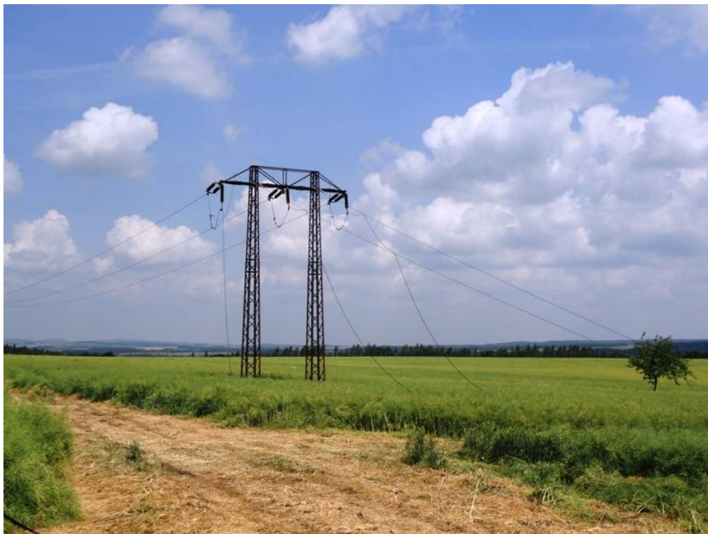
Sejmutí starého vedení a portálových stožárů v poli
