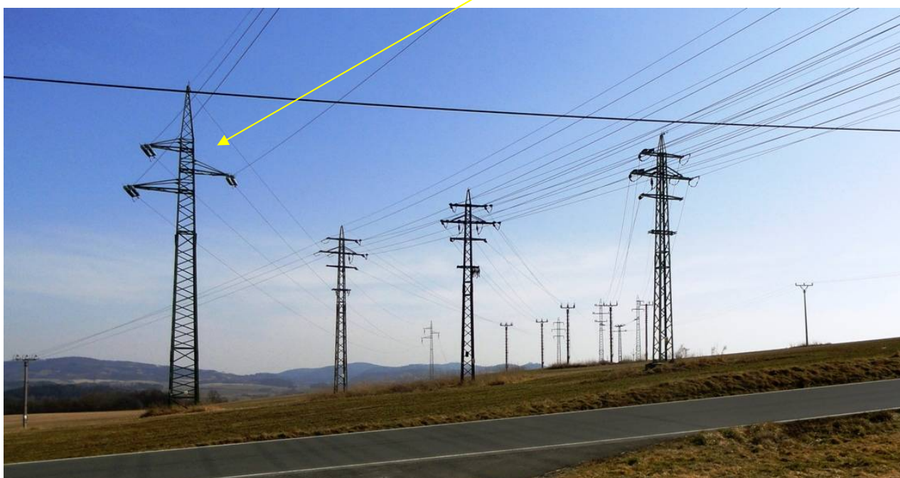
FOTO č. 3: Skupina výstupů z RODO směr JZ, linka do Kdyně je vlevo
