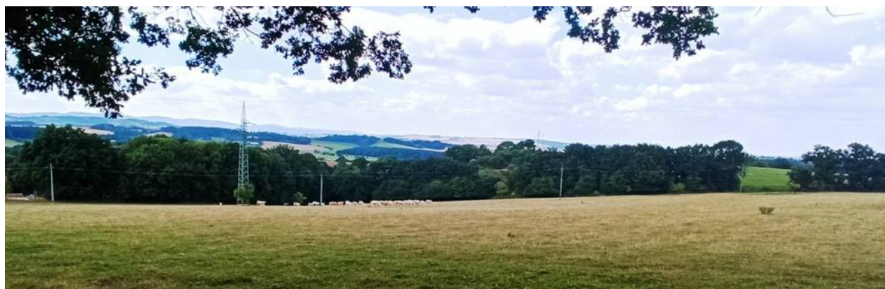
FOTO č. 11.: Trasa u ST 31 nad Starým Dvorem
