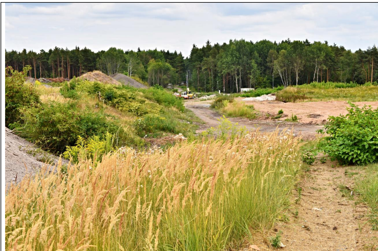
Pohled na vjezd od západu
