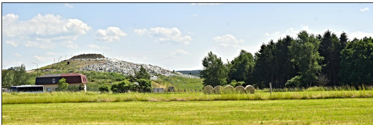
Pohled na skládku a les z jižní strany
