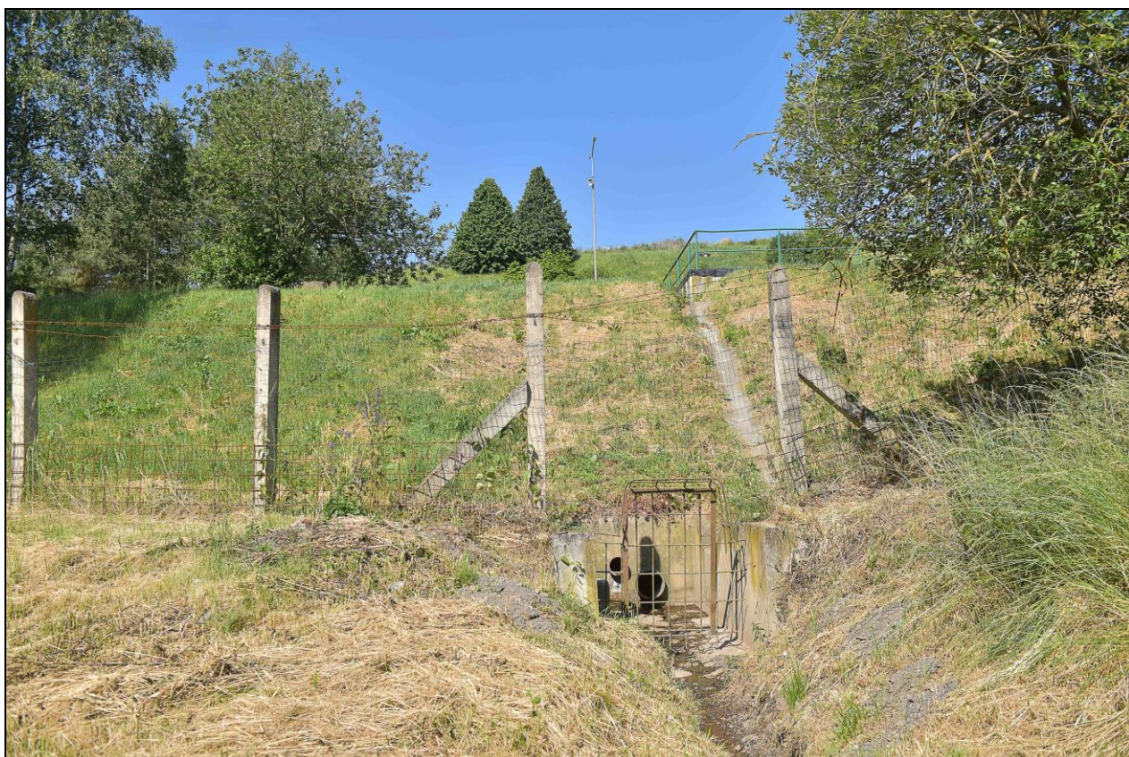
Okraj staré skládky, odvodnění
