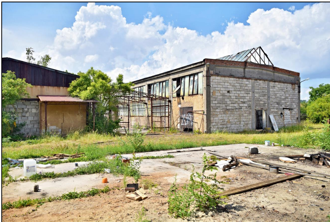
Pohled na demolované objekty od západu
