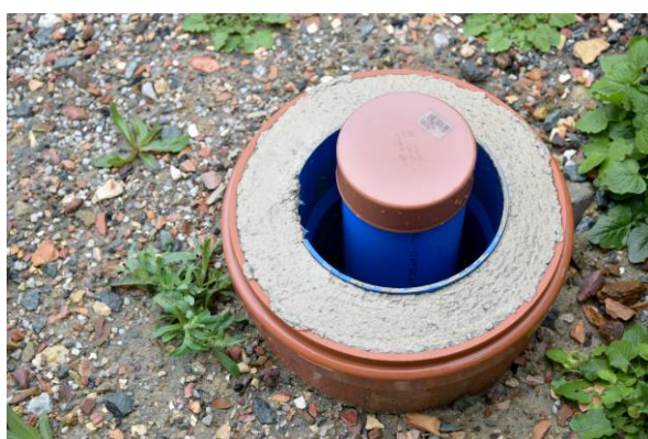
Zhlaví monitorovacího vrtu MV 1
