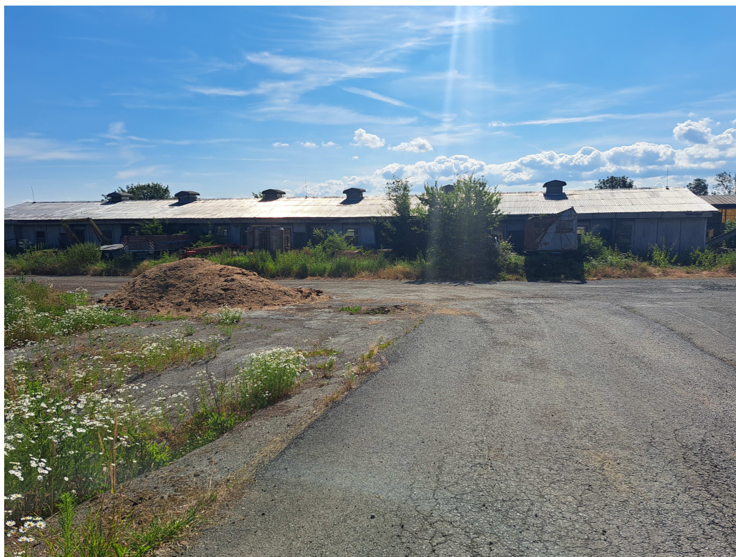
Pohled na stáj určenou k demolici
