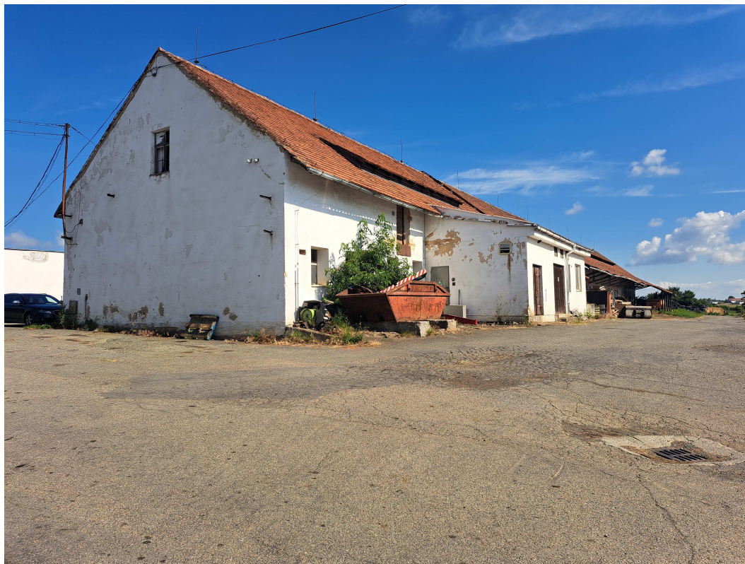
Pohled na stáj určenou k demolici
