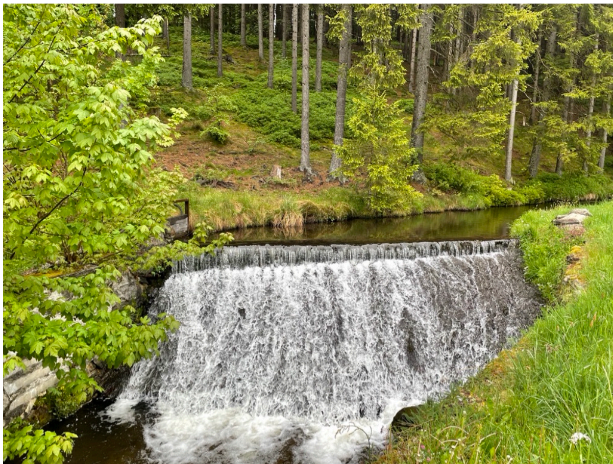
Obr. 3 – spádový stupeň na oku Řezné v prostoru campu, 5/2024 (zdroj vlastní)
