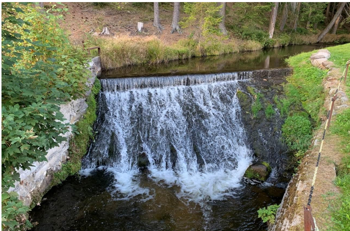
Spádový stupeň na toku Řezné v prostoru Campingu v Železné Rudě (foto: 16.9.2020, TK).
