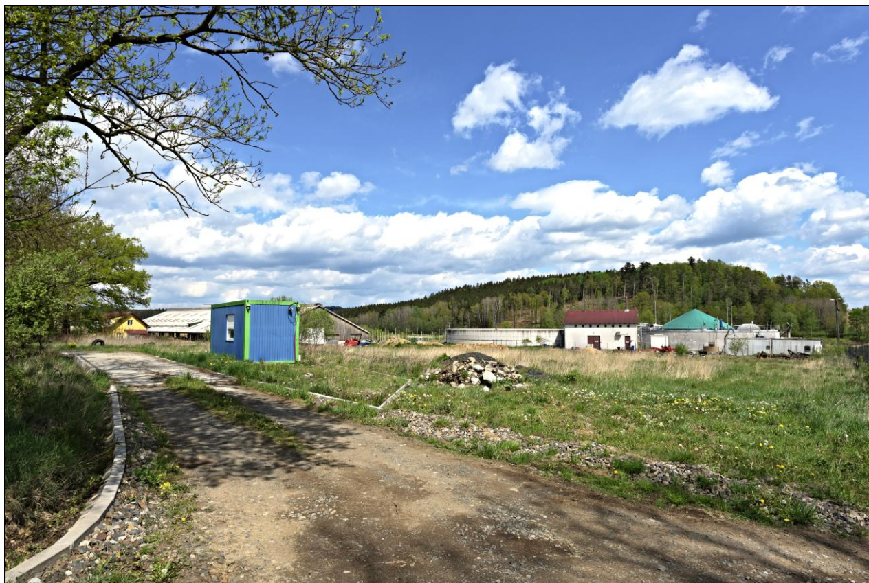
Vlevo mostová váha s kontejnerem pro obsluhu, napravo místo stavby stáje č. 4
