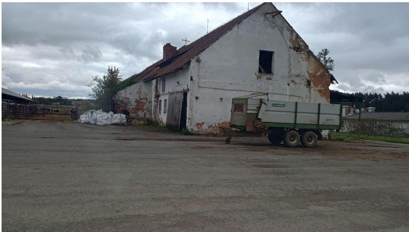
Severní pohled na stávající stáj č. 2
