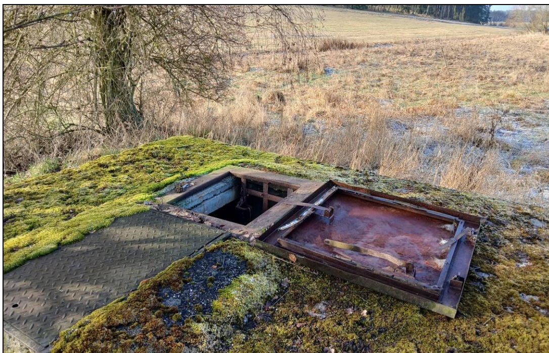
Obr.č.5: Pohled na šachtici vrtu v Pláni se vstupním poklopem
