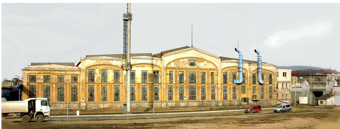
Současný stav průčelí budovy Techmania (PJ 55)
