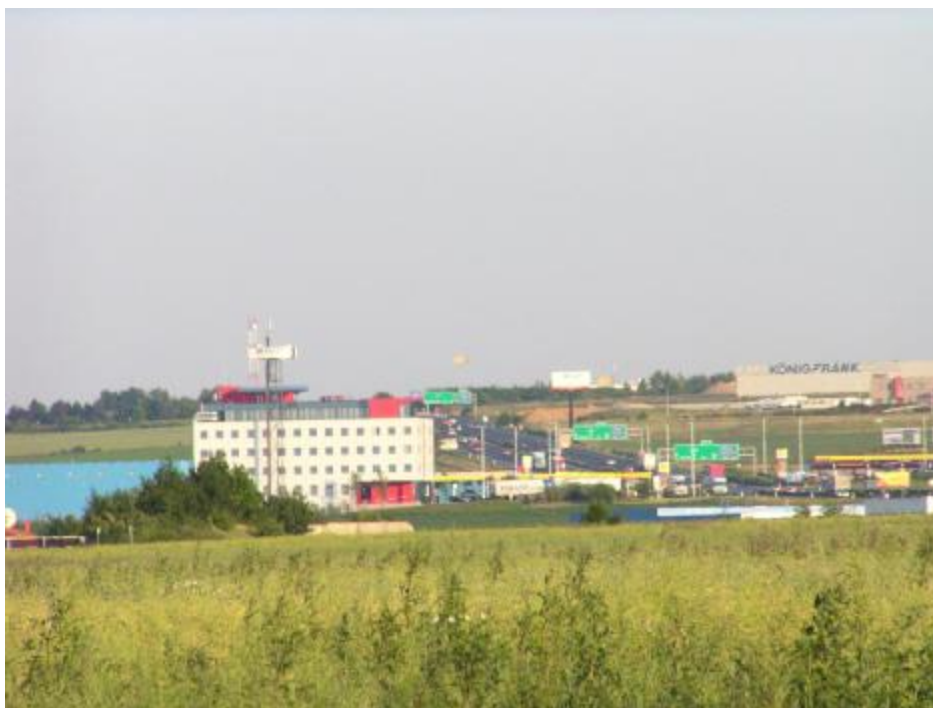
Foto č.4: Pohled na lokalitu – v popředí pozemky areálu dostihové dráhy, v pozadí areál Czech International
