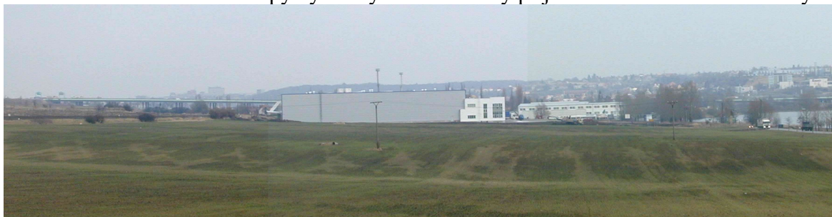
Celkový pohled na budoucí staveniště II. etapy se současným stavem ( v popředí sklad 01 TP I. etapy, vpravo Bóllhof) ve směru od Hostivice
