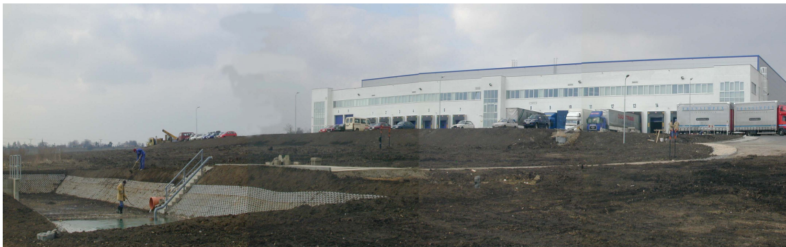
Panoramatický pohled na sklad SO 01 I. etapy výstavby přes retenční nádrž
