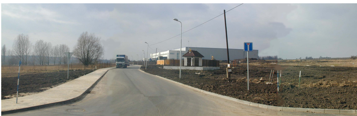
Pohled na staveniště I. etapy výstavby od křižovatky příjezdové komunikace Palouky
