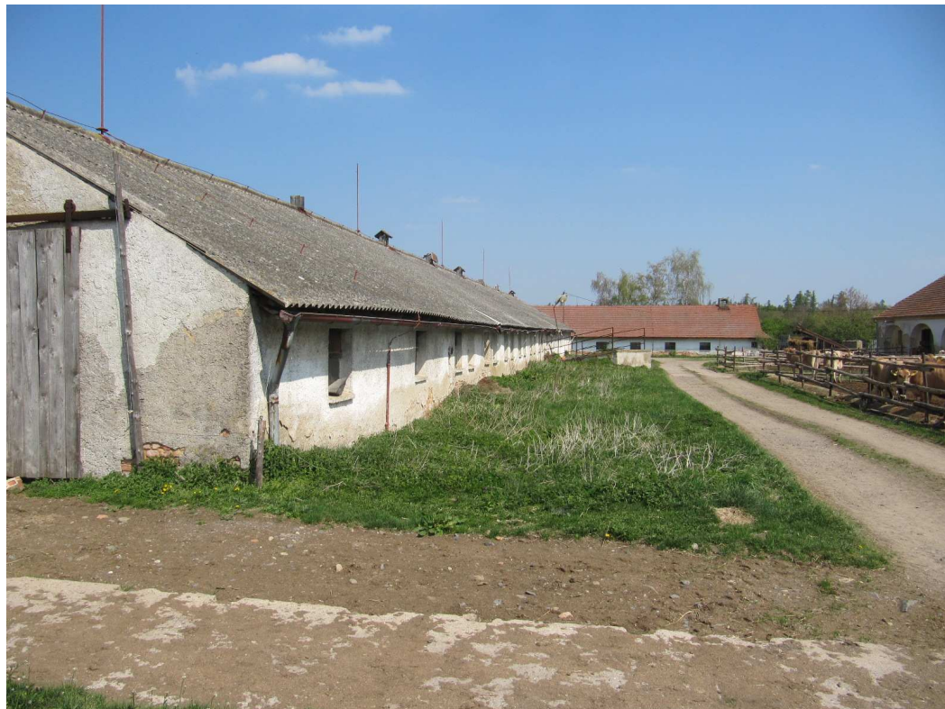
Pohled na stáj určenou k demolici
