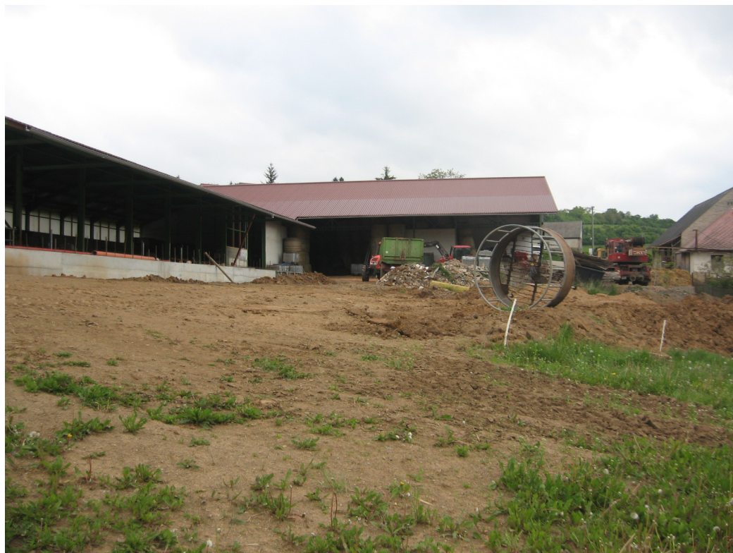
Pohled na místo stavby
