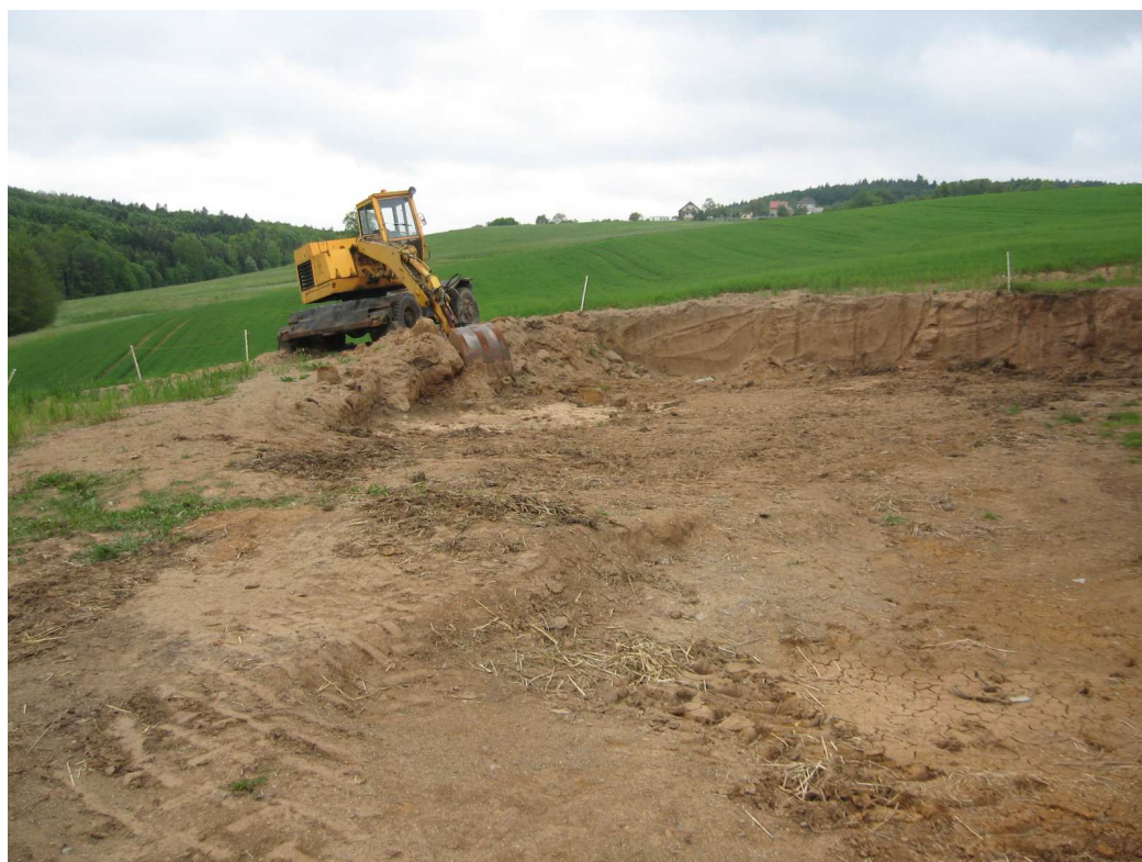
Pohled na místo stavby
