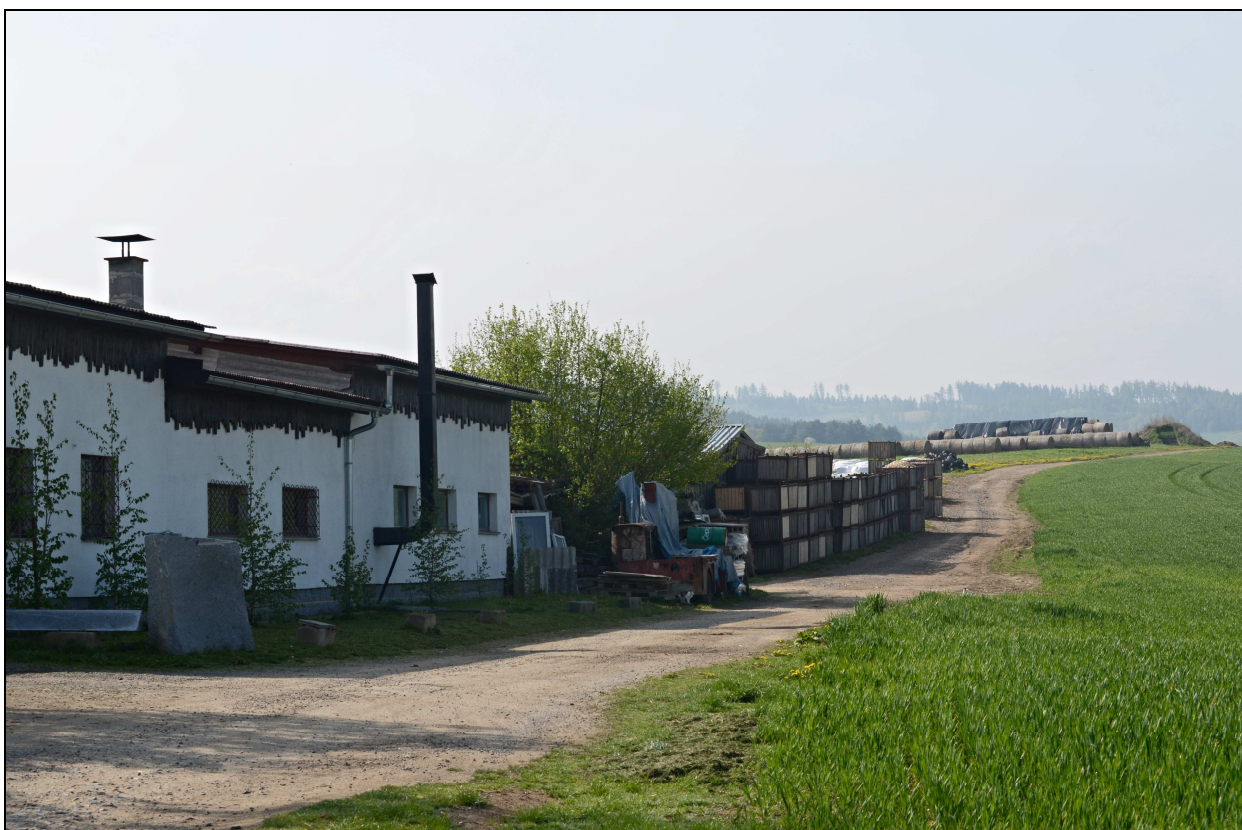
Pohled na místo stavby (vlevo) od přístupové cesty
