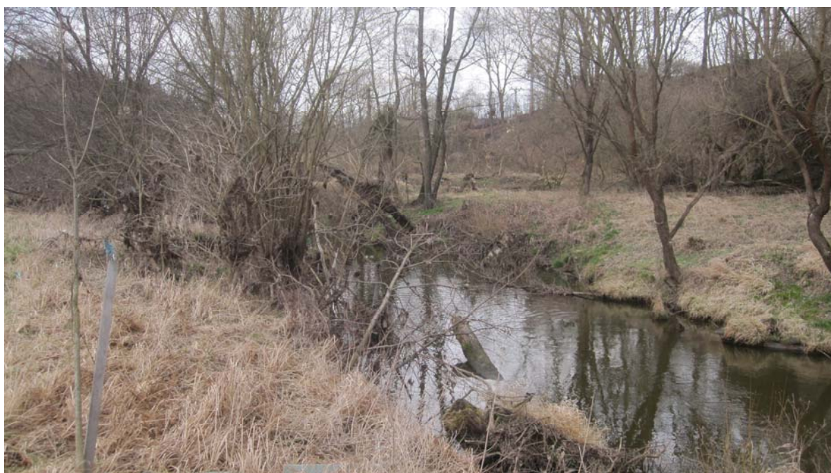
pohled na řeku Blanice v místě křížení s plynovodem, protlakem
