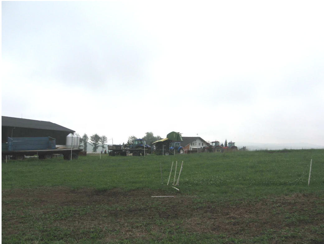
Pohled na místo stavby (v pozadí stávající obytný objekt)
