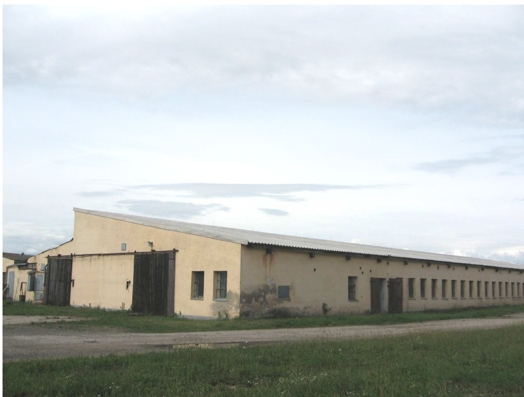
Pohled na místo stavby
