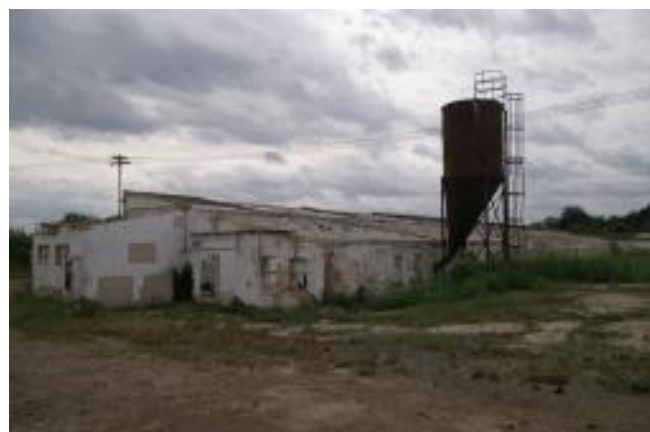
Pohled od vjezdu do areálu
