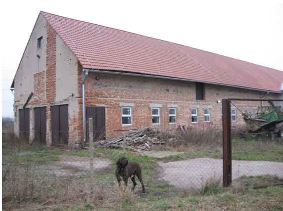
Pohled na místo umístění fermentoru a příjmové jímky
