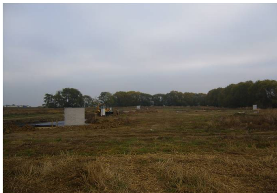
Budování nových rodinných domů a infrastruktury v sousedství záměru (jihozápadně od řešeného území).
