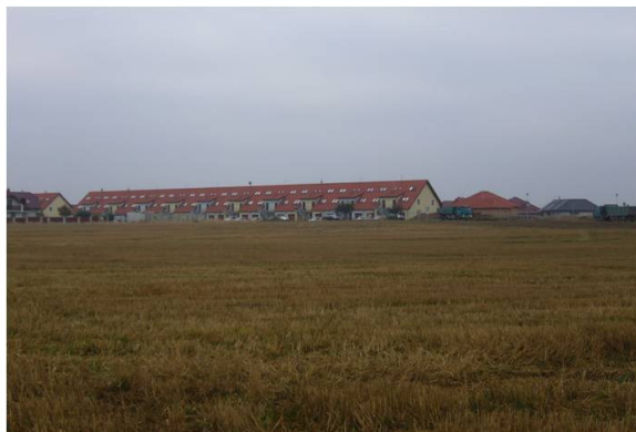
Pohled na stávající zástavbu v okolí záměru.
