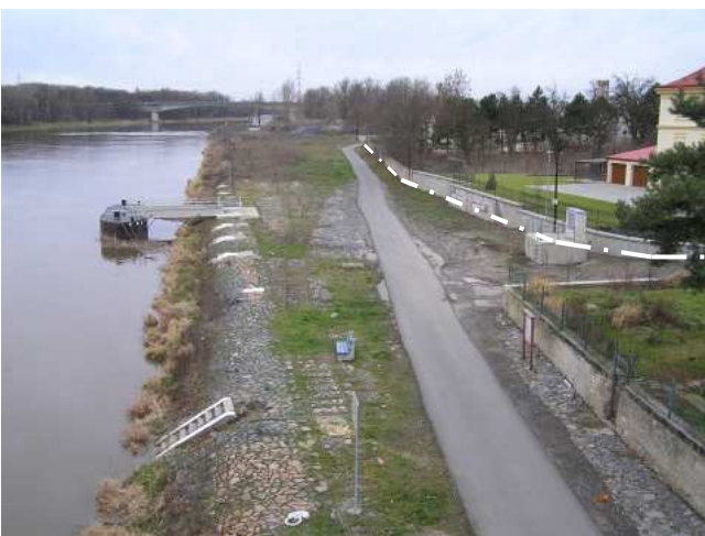
pohled na jižní okraj lokality Vinařství ze silničního mostu
