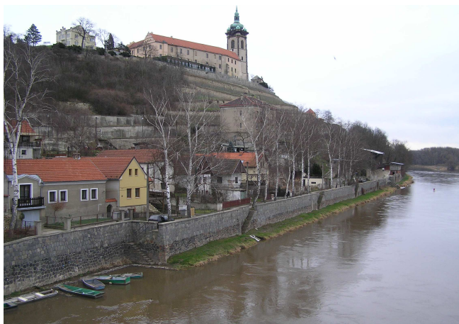
zájmové území lokality Rybáře (foto od starého silnič. mostu proti proudu Labe) – nábřežní zeď a přilehlá linie v budoucnu chráněné zástavby, nahoře v pozadí zámek Mělník a vinice na svahu pod ním, v pozadí loděnice
