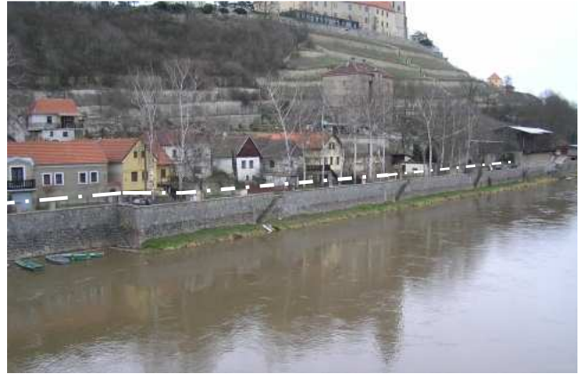
lokalita Rybáře – vyznačena zhruba úroveň koruny protipovodňové bariéry (převážně mobilní hrazení)
