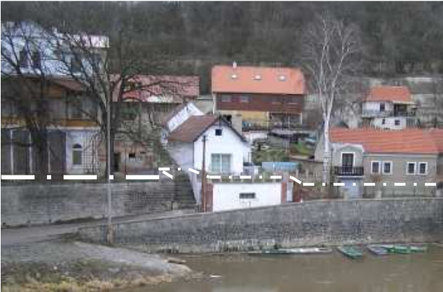
severní část lokality Rybáře – vyznačena zhruba úroveň koruny protipovodňové bariéry
