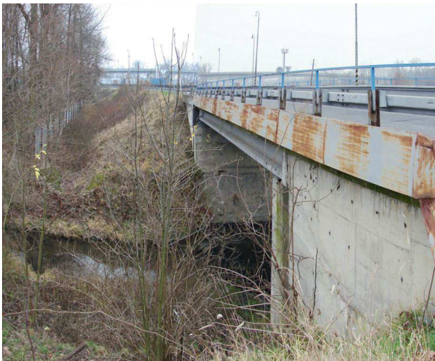
silniční most na říčce Pšovce (návodní strana), v profilu má být umístěna protipovodňová čerpací stanice a uzávěr Pšovky
