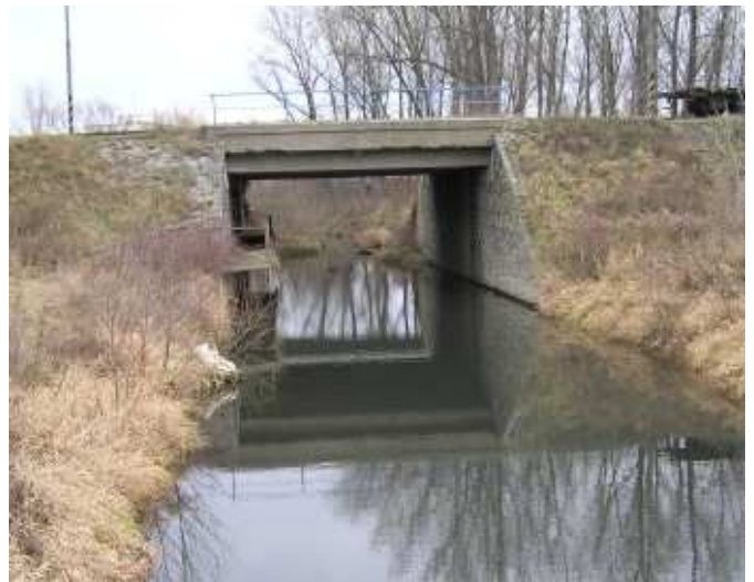
silniční most na říčce Pšovce – profil protipovodňového uzávěru, pohled proti proudu
