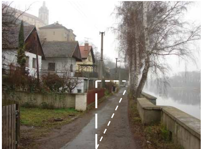
obytná zástavba v lokalitě Rybáře – vyznačen zhruba obrys protipovodňové bariéry (mobilní hrazení)
