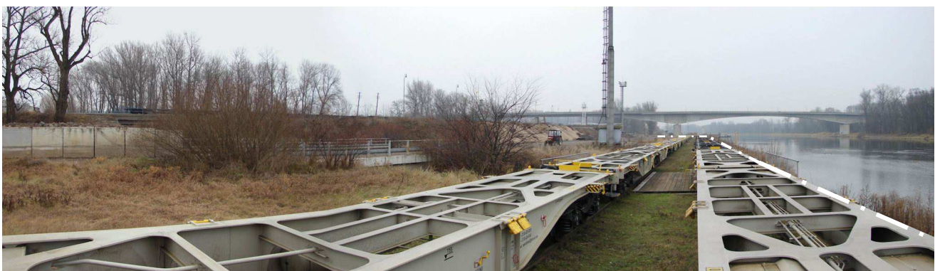
areál Českých přístavů, pohled proti proudu – trať železniční vlečky na břehu Labe, v pozadí most silnice I/16
