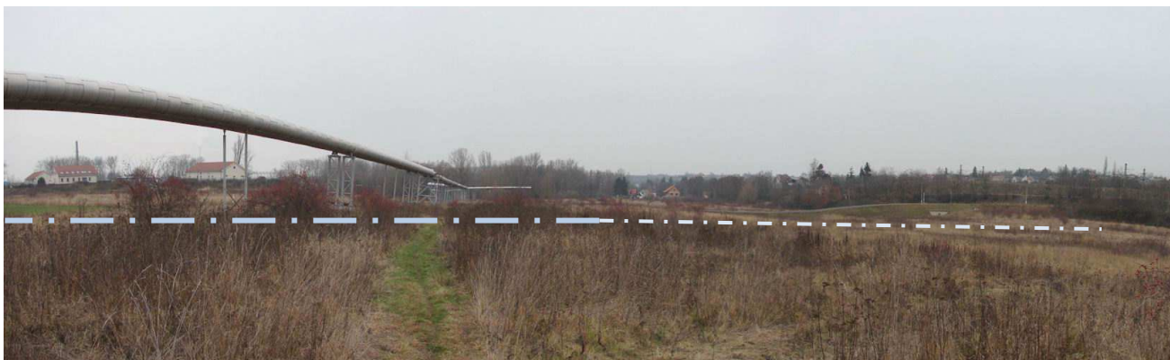
severní okraj linie PPO, přibližné místo křížení linie PPO s produktovodem, vlevo v pozadí ČOV, vpravo navazuje ulice Českolipská (vyznačena přibližná linie PPO)
