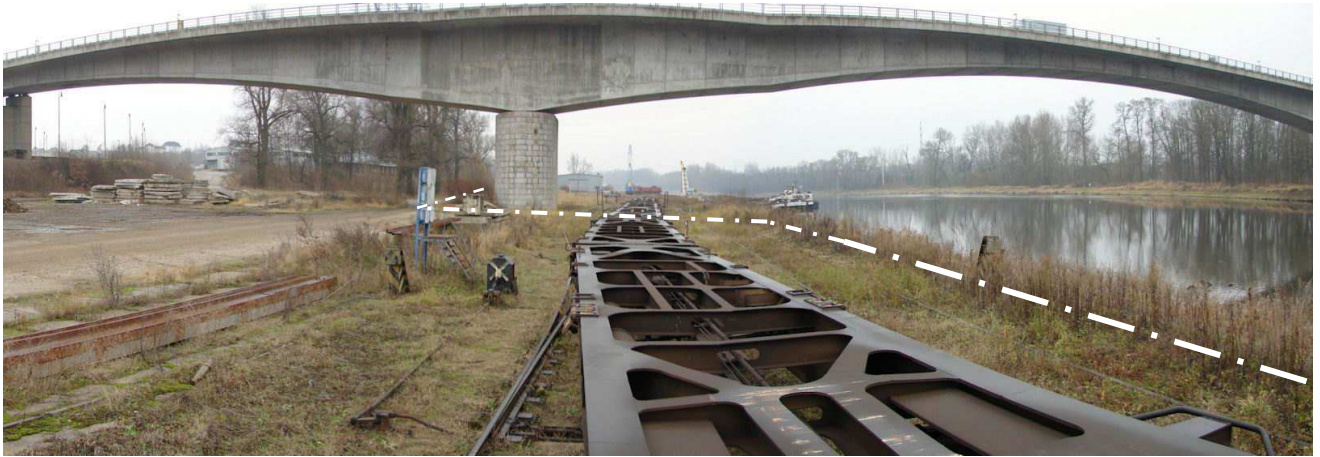
areál Českých přístavů, silniční most (komunikace I/16), pohled proti proudu
