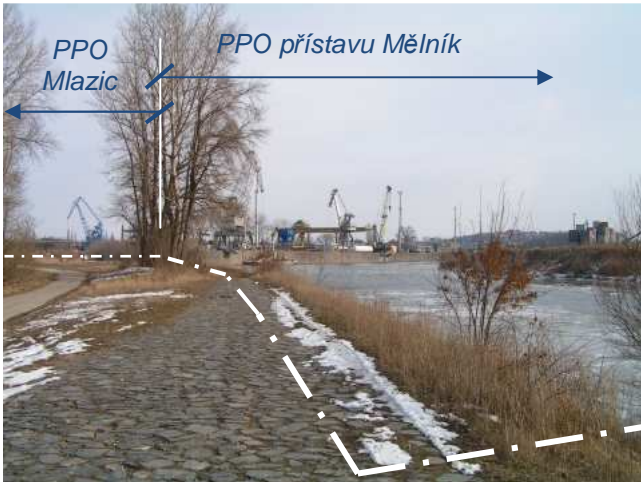
trasa linie PPO podél vjezdu do přístavu, pohled zhruba z místa budoucího profilu uzávěru vjezdu do přístavu
