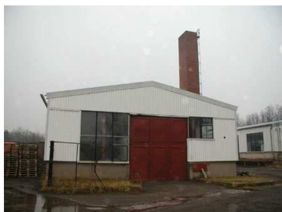
objekt bývalé kotelny (bude zlikvidován)
