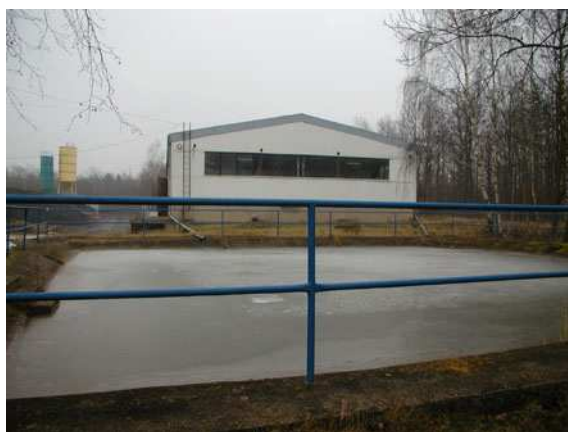
požární nádrž, v pozadí hala
