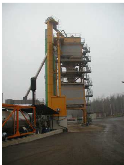
věž stávající obalovny
