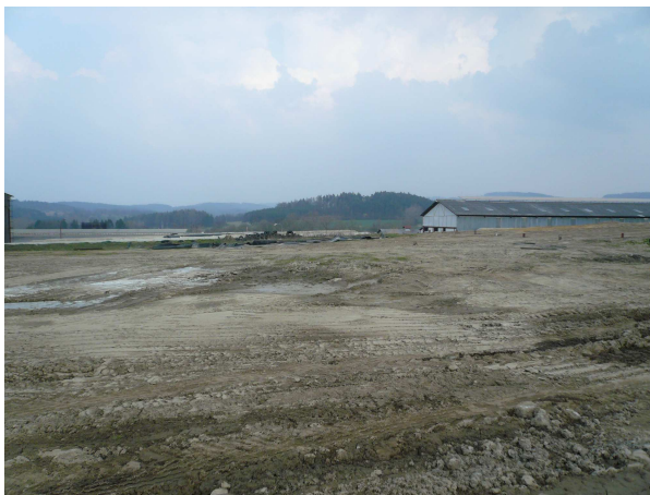
Pohled na místo výstavby BPS
