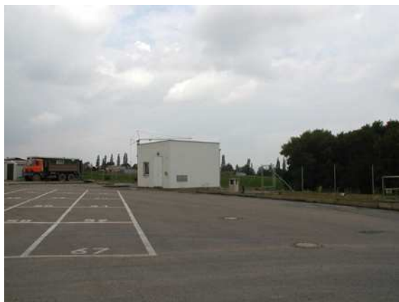
objekt čištění vod - vpravo retenční nádrž
