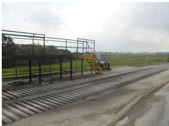
objekt postřiku korb - bude používán i novou obalovnou
