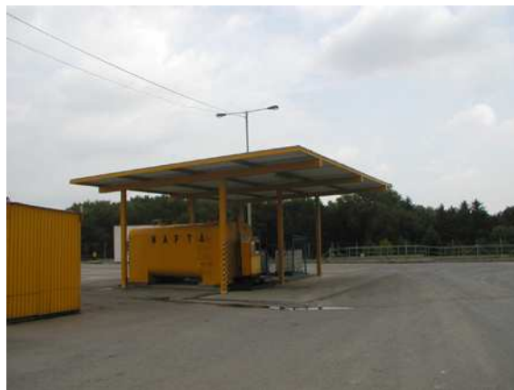
čerpací stanice nafty
