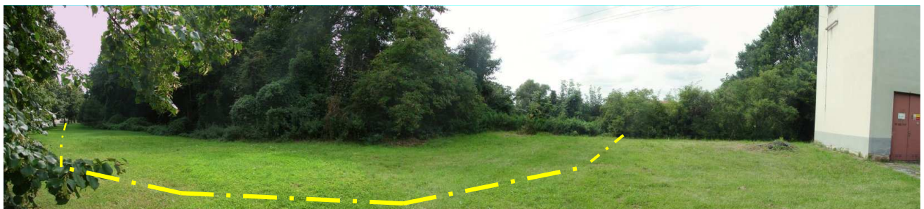
západní až JZ část linie PPO (cca 1,3 m vysoká hrázka) – pohled k západu (naznačena linie PPO)
