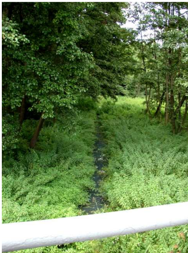
Sokolečská strouha severně od křížení silnicí II/611 – pohled k severu
