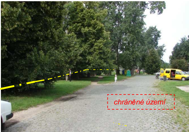
střední až západní část linie PPO, v pozadí labské nábřeží a plavební komora (cca 0,5 vysoká zídka) – pohled k západu (naznačena linie PPO)
