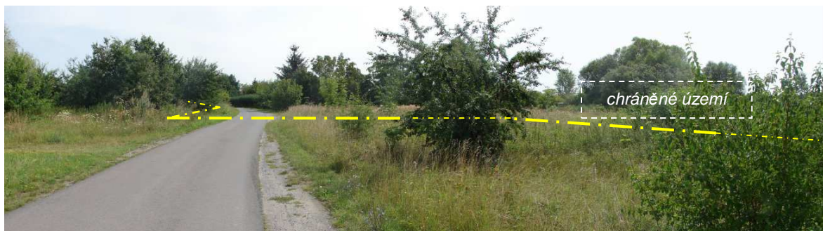
severní část linie PPO (cca 1,3 m vysoká hrázka) – pohled k SV (naznačena linie PPO)
