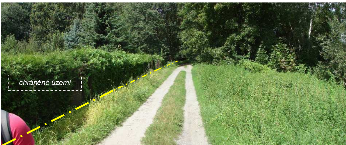
střední část linie PPO (cca 1,4 m vysoká zeď v linii oplocení) – pohled k severu až SZ (naznačena linie PPO)
