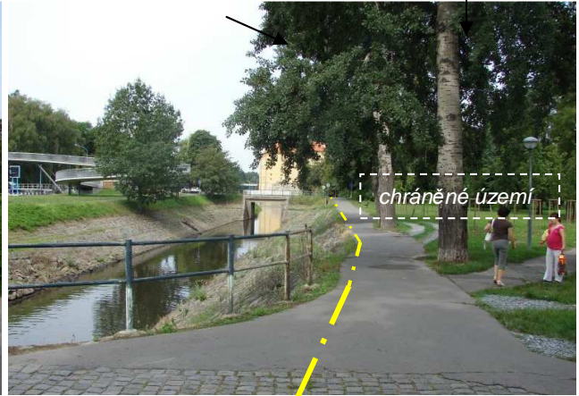
západní část linie PPO – spodní stavba mobilního hrazení (hrazení do cca 1 m výšky) – pohled k SZ
