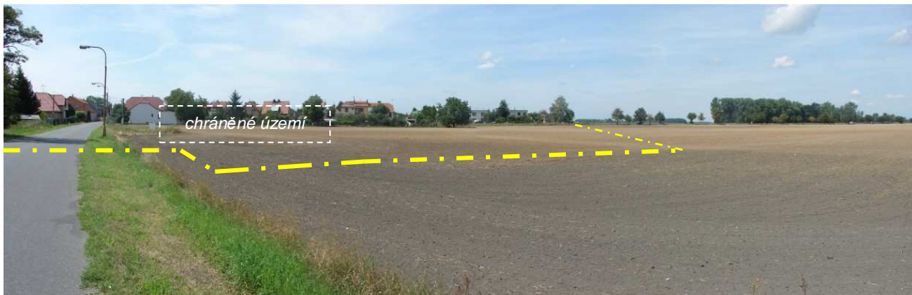
severní část linie PPO (cca 1 m vysoká hrázka) – pohled k SZ (naznačena linie PPO)
