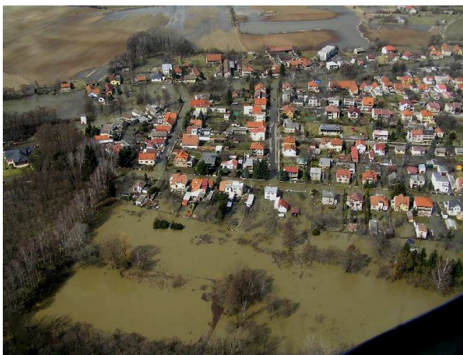
obec Polabec – pohled k severu – v popředí oblast odvodňovací strouhy a hřiště, dále v popředí ulice Růžová a ulice Lesní a Zahradní
