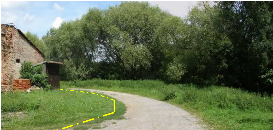
jižní až střední část linie PPO (cca 1 m vysoká zeď) – pohled k severu (naznačena linie PPO)
