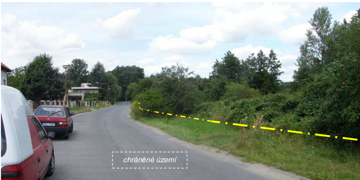
severní část linie PPO (cca 0,8 až 1,2 m vysoká hrázka) – pohled k severu (naznačena linie PPO)
