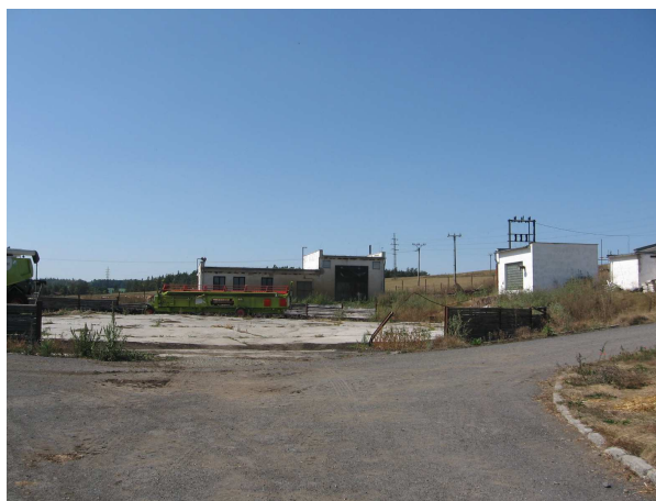
Pohled na místo výstavby BPS
