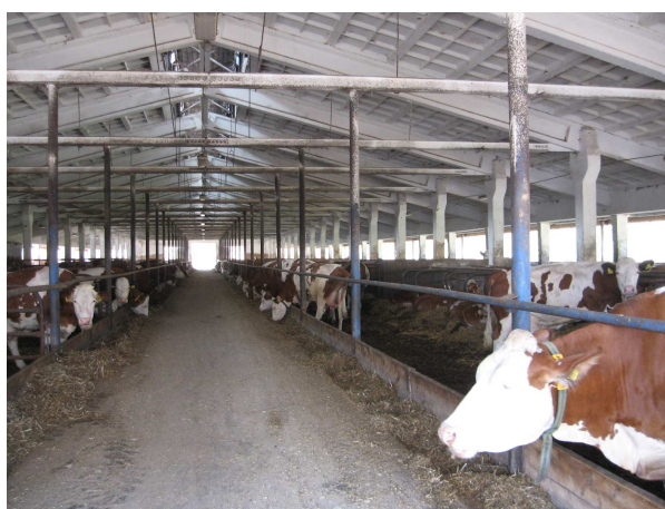
Pohled do stáje určené k rekonstrukci
