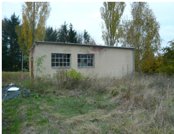
Pohled na pozemek pro umístění kogenerační jednotky a budovu zázemí BPS
