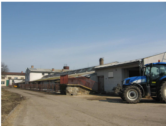
Pohled na místo výstavby BPS
