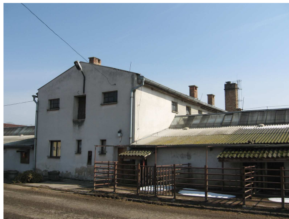
Pohled na budovu pro umístění zázemí BPS
