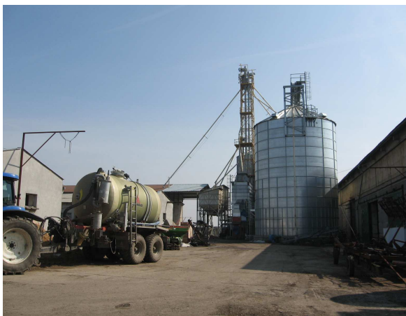
Pohled na místo výstavby přečerpávací jímky na digestát
