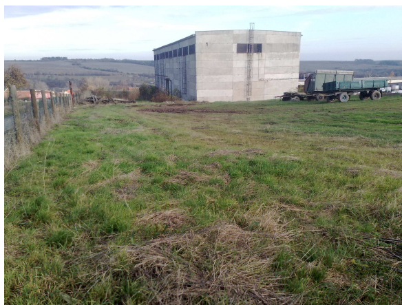
Pohled na místo výstavby BPS
