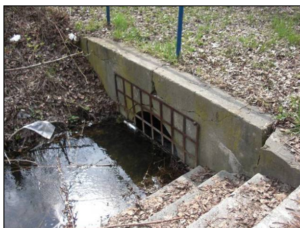
Foto č. 4: Pohled na zatrubnění vodního toku
