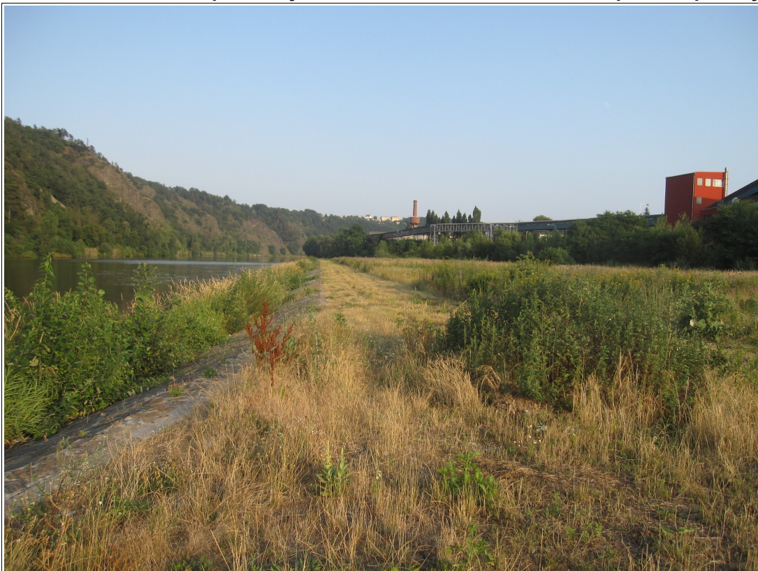
Obr. 4. Říční břeh opevněný kamennou dlažbou, travnatá pláň náplavky.
