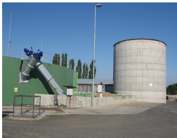
Pohled na plynojem, vlevo dávkoč a fermentor
